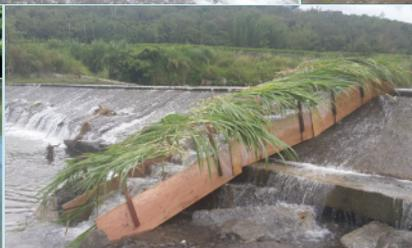
早期製作的攔河堰經長期河水沖刷，結構已經有部分破損，導致溪中生物上溯困難。面對洄游物種上不去的圍牆（潭埔堀），我們就做一個梯子助他們一臂之力吧！在地居民自發性的用木材、鐵絲等材料，做了臨時魚道，讓洄游性的魚蝦都可以順著魚道往上游。試過各種材料與方法，歷經三代的臨時魚道實驗，終於成功讓部分的溪流魚類順著魚道而上，牠們的回家之路又向前進了！
